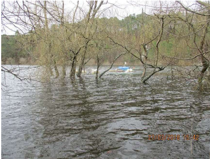
Figure 16 : Vue du ponton flottant des pompes immergées de la carrière Le Gallic
