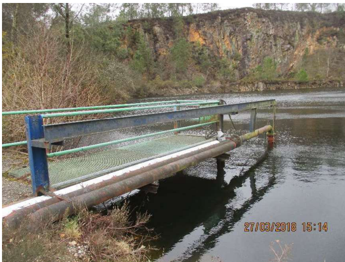
Figure 15 : Vue du ponton de prise d'eau de la carrière Barazer
